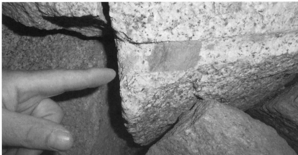
Foro da mina, con resti dell'argilla di borraggio
