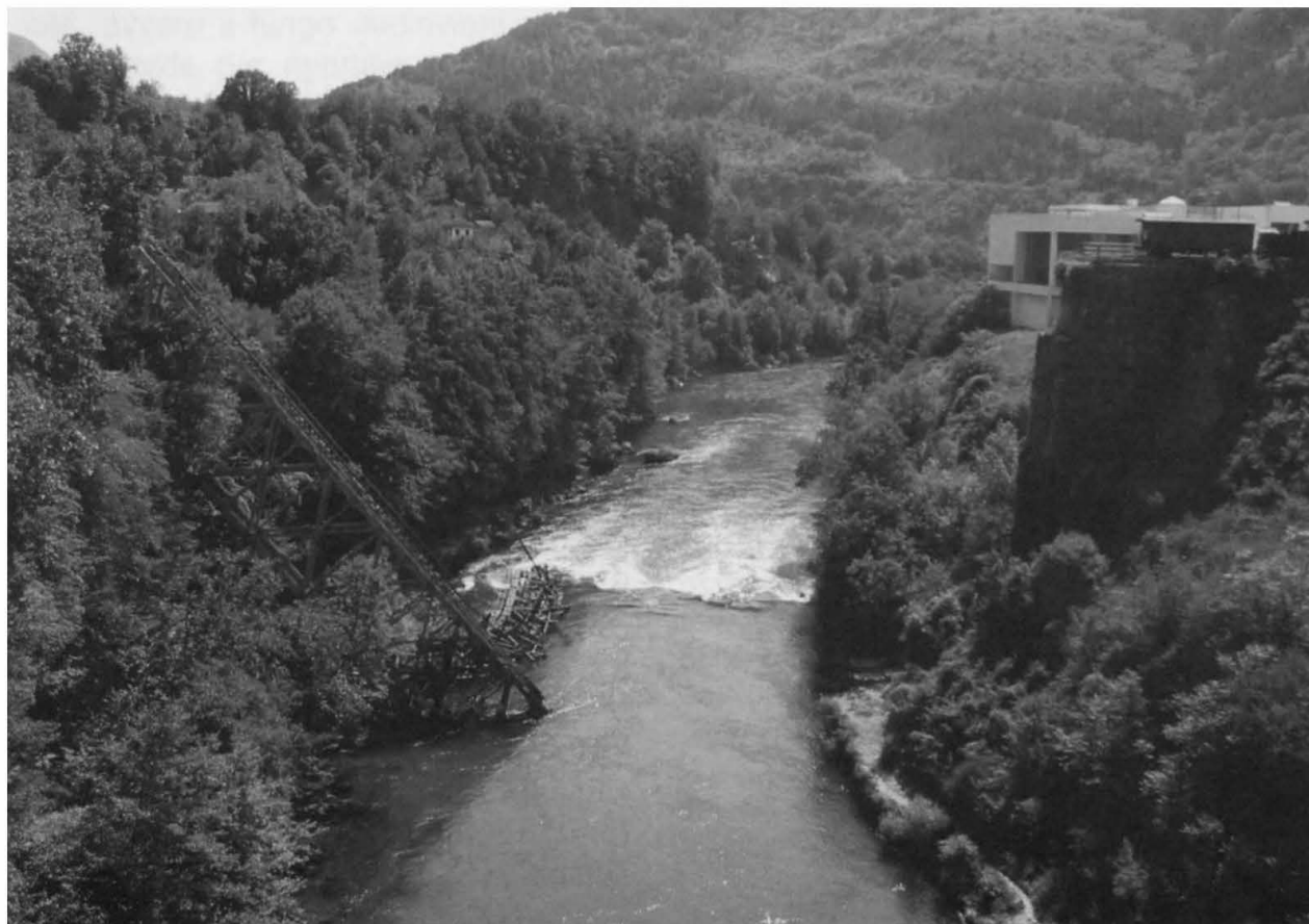
Lungo la strada
