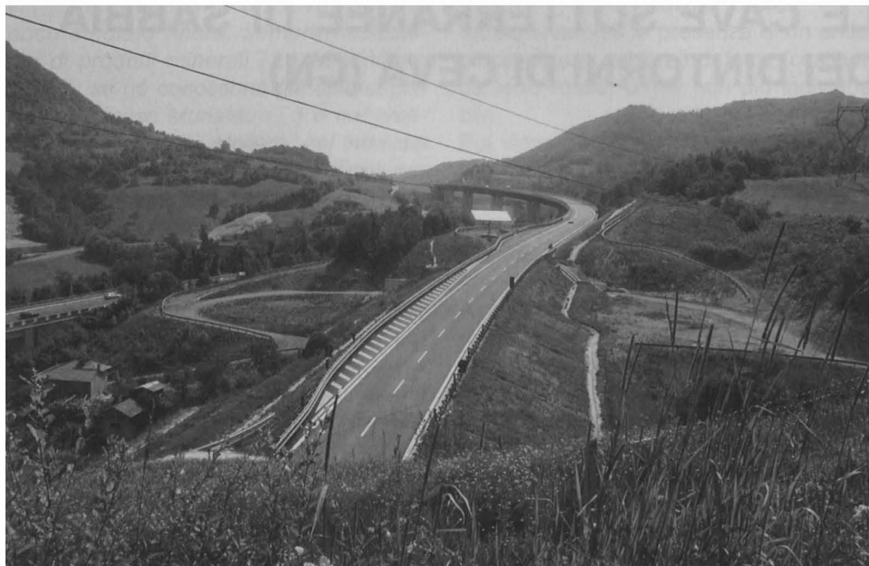
Sopra l'imbocco della nuova galleria autostradale del Bric Tana, nel versante est. In basso a sinistra si intravede Cascina Genta.
