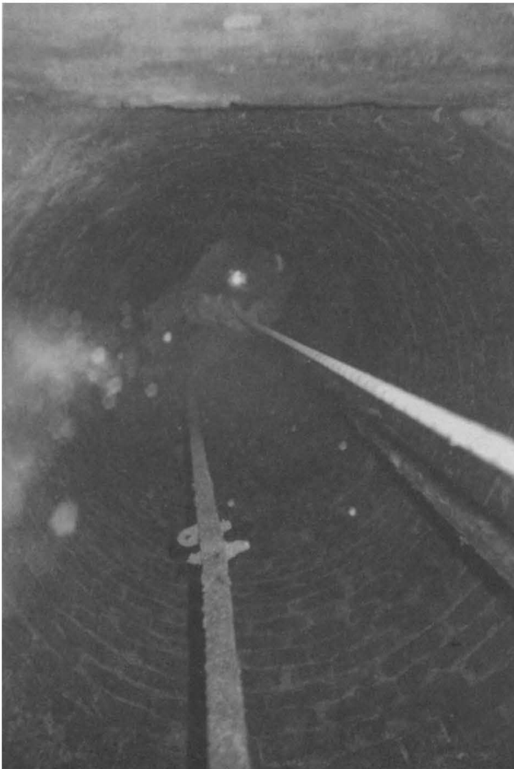
Pozzo della Caldaia: accesso
