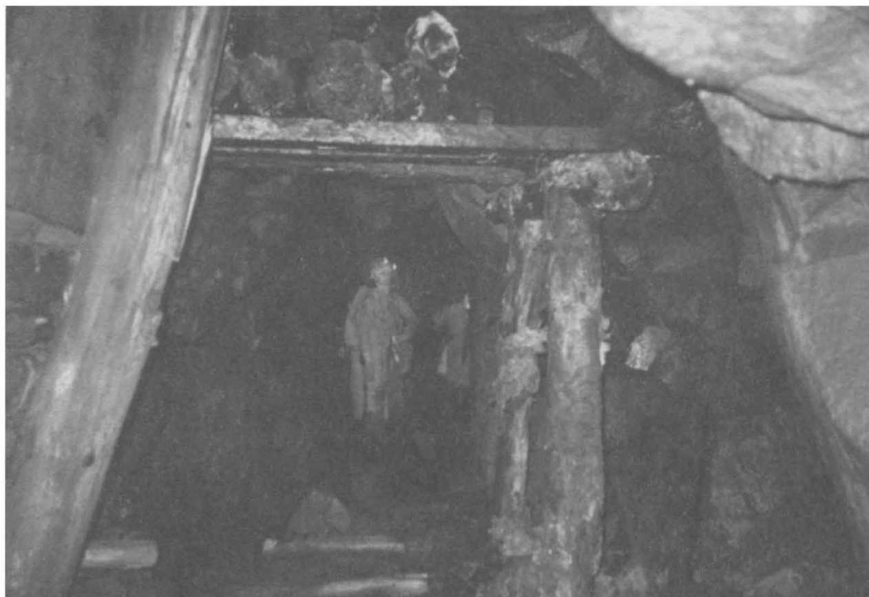
Armo della galleria di saggio presso il deposito esplosivi
