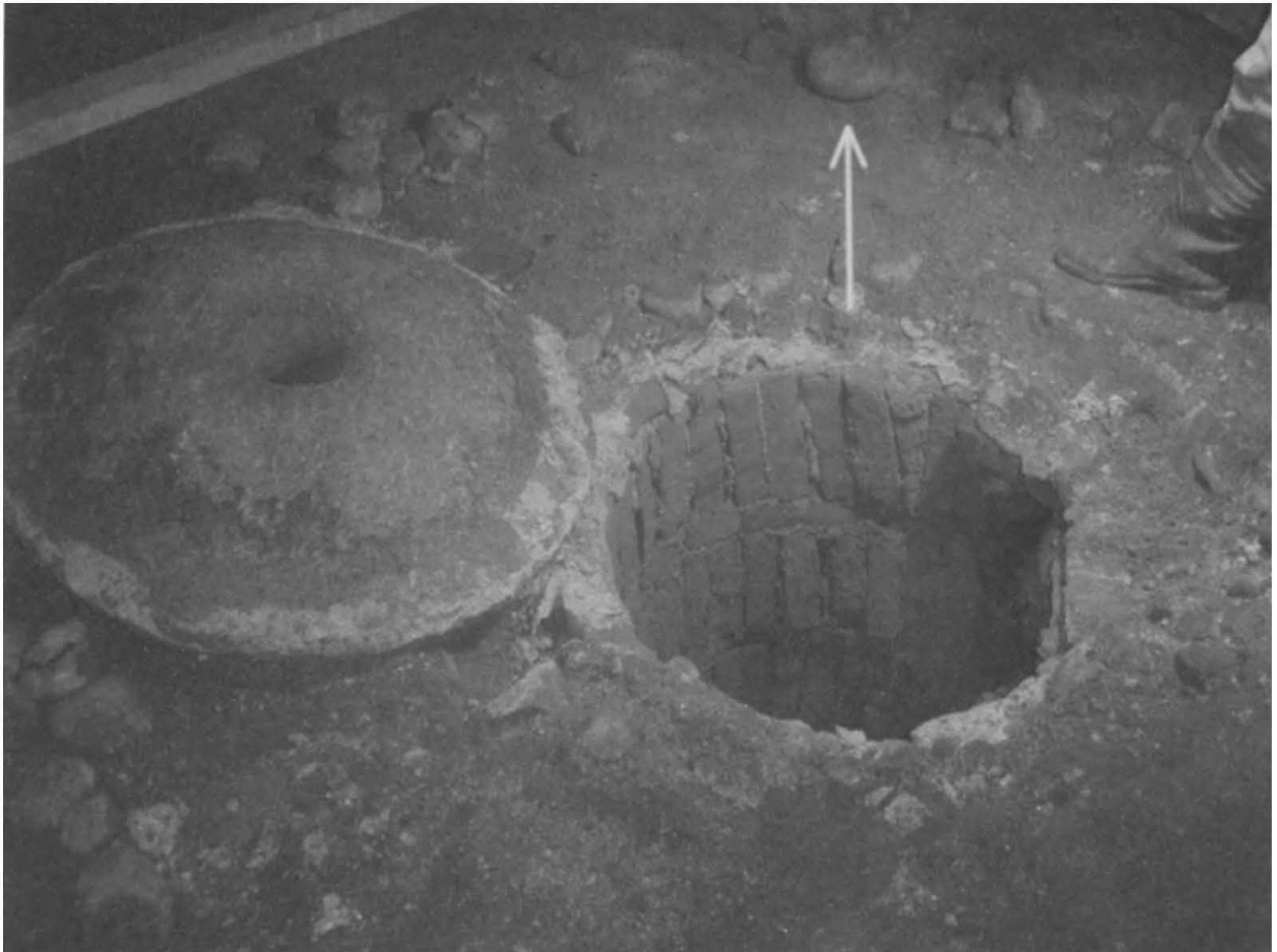
Pozzo della Ghiacciaia: copertura completa di tappo
