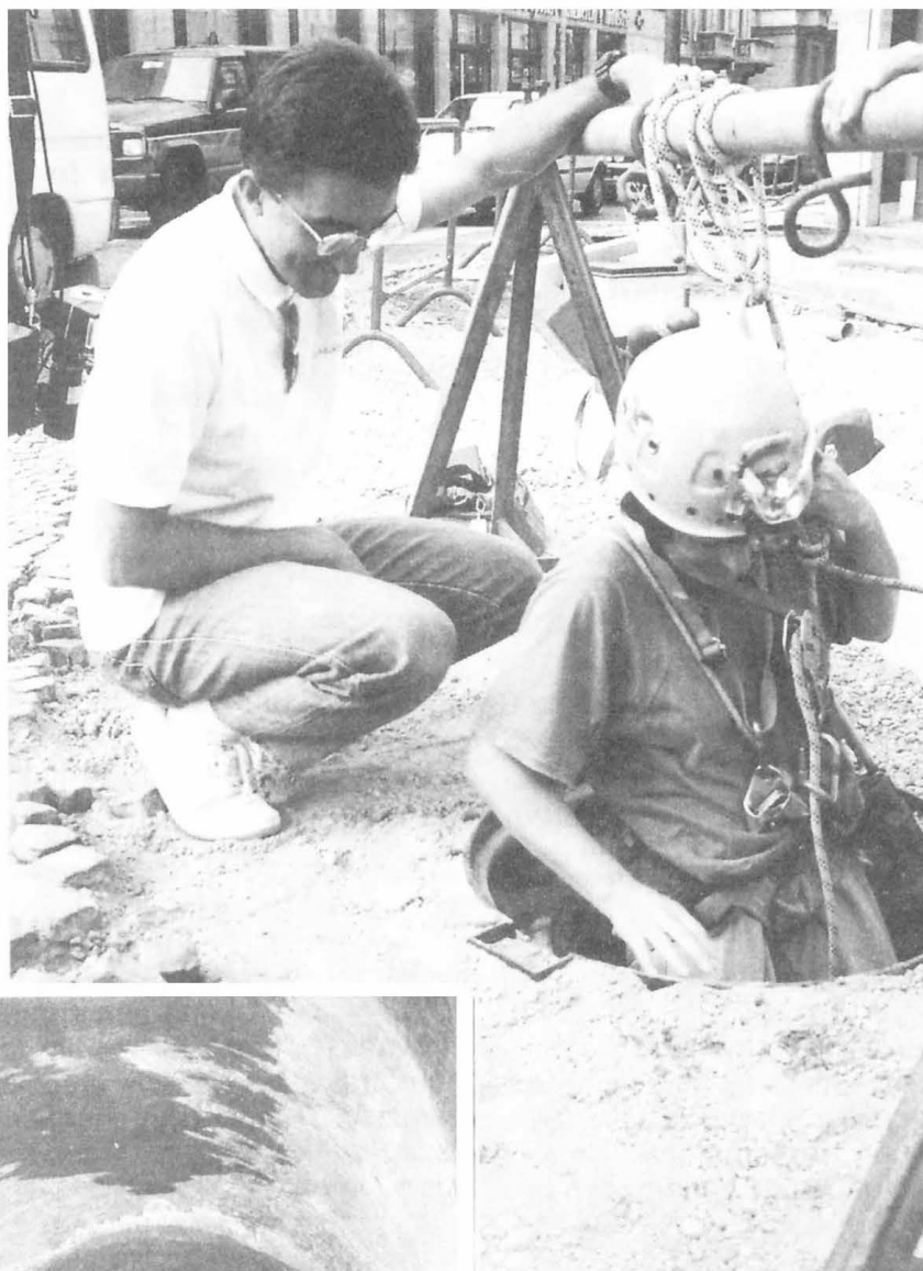
Accesso alla cisterna di Piazza Cavour
